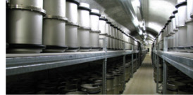
Regallager im Stollen.
